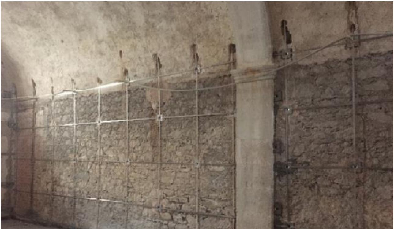
Figura 1 – Edilizia storica e vincolata in muratura
