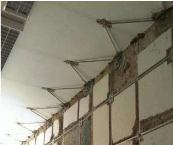
Figura 50 - Arpionatura dei travetti: intervento all'intradosso
