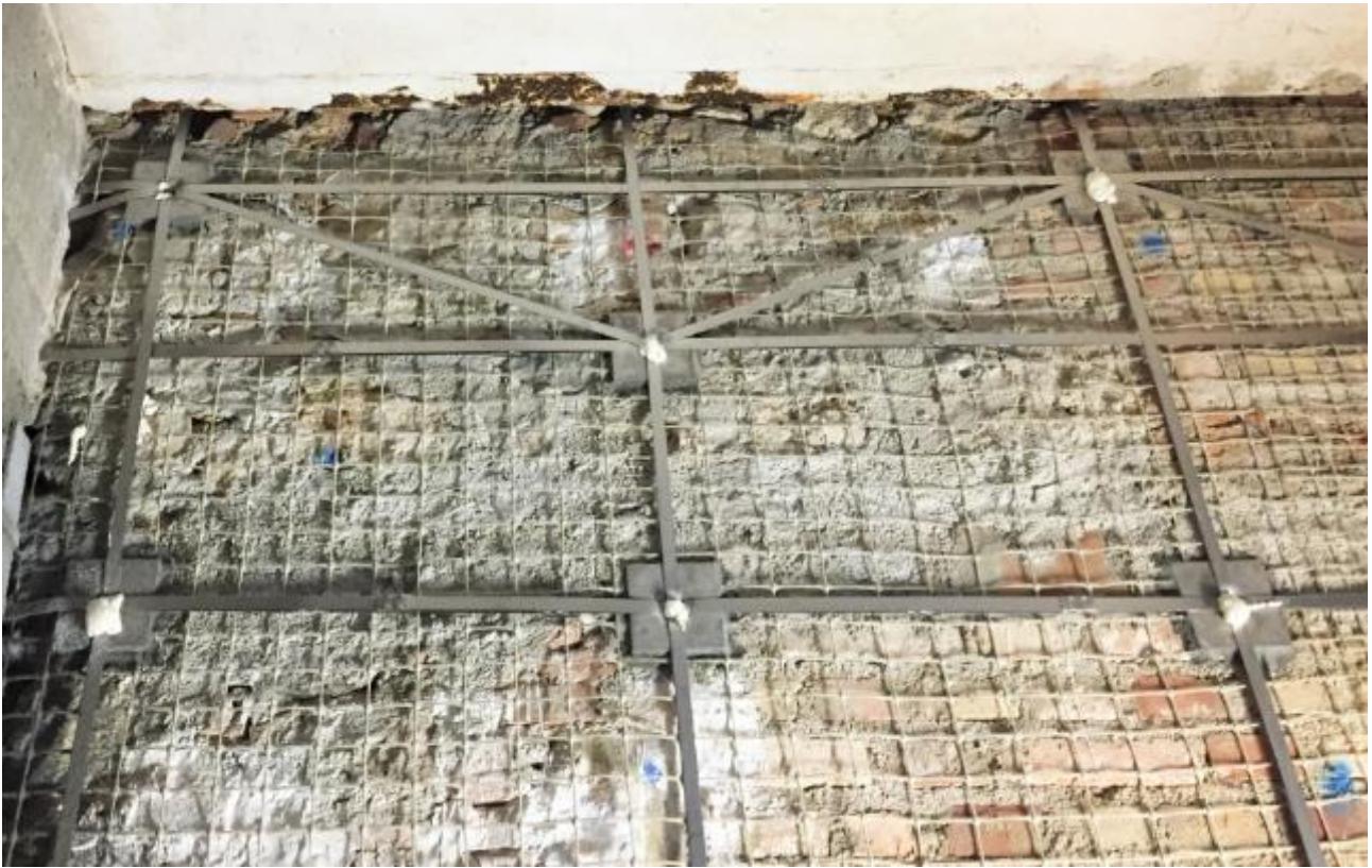
Figura 39 - Applicazione EDIL CAM Sistemi con reticolo CAM ® in combinazione alla rete TENAX-RF2
