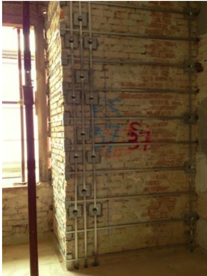
Figura 64 - intervento con nastri di spigolo
