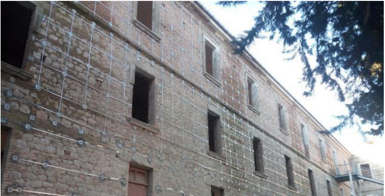
Figura 23 - Lavorazione Edil CAM Sistemi s.r.l. su facciata di un edificio scolastico
