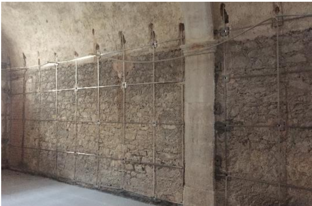
Figura 28 - Lavorazione Edil CAM Sistemi s.r.l. su fabbricato storico
