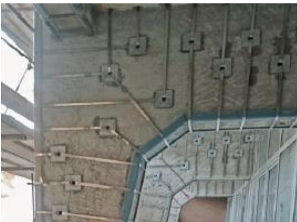
Figura 2 – Strutture in calcestruzzo armato
